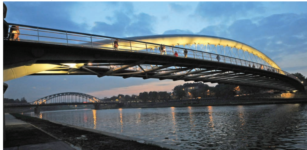
Kładka ojca Bernatka
